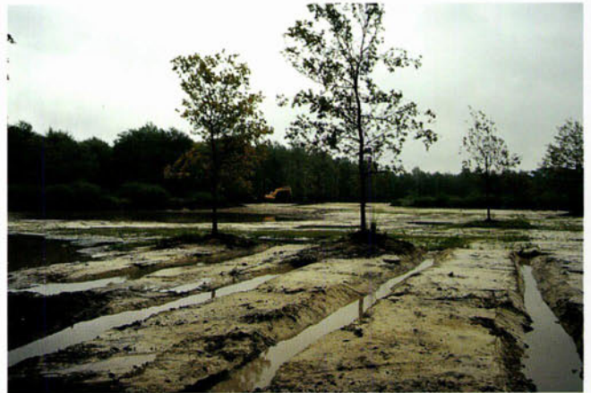
FIGUUR 7 Venherstel in uitvoering in het Klein ven ten zuiden van de Grashut (september 2000). Ook uit de greppels wordt de veraarde, geëutrofiëerde bovenlaag verwijderd (foto: J. Hoogveld).
