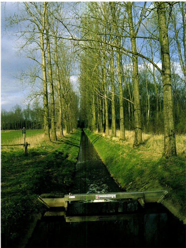
FIGUUR 1 De Oude Graaf zorgt voor de afwatering in het Weerterbos. Door de aanwezigheid van diverse stuwen wordt vismigratie verhinderd (foto: A.J.W. Lenders).
